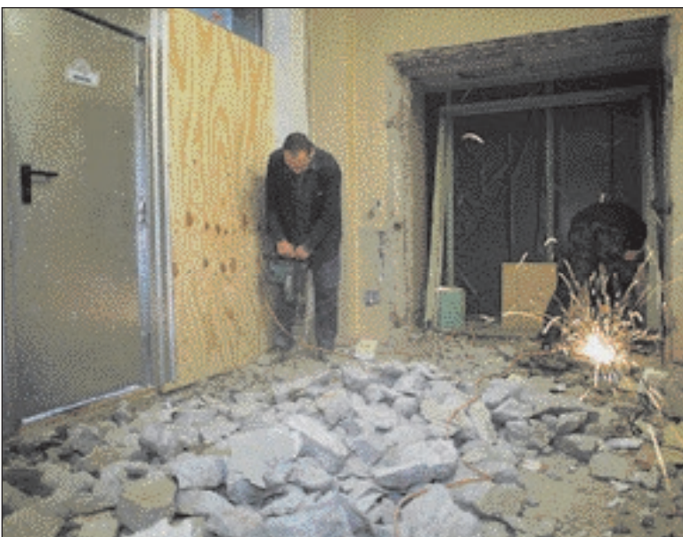
Im Zuge der Umbauarbeiten des Ganges 8 im Schweriner Klinikum müssen insgesamt rund 1500 Quadratmeter Estrich aufgestemmt werden. Um Lärm- und Staubbelastung so gering wie möglich zu halten, wird der Gang komplett gesperrt und abgeschirmt Foto: max
