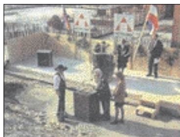
Grundsteinlegung für die neue biologische Reinigungsstufe am 11. Oktober 1991 durch OB Johannes Kwaschik und MV-Umweltministerin Dr. Petra Uhlmann
