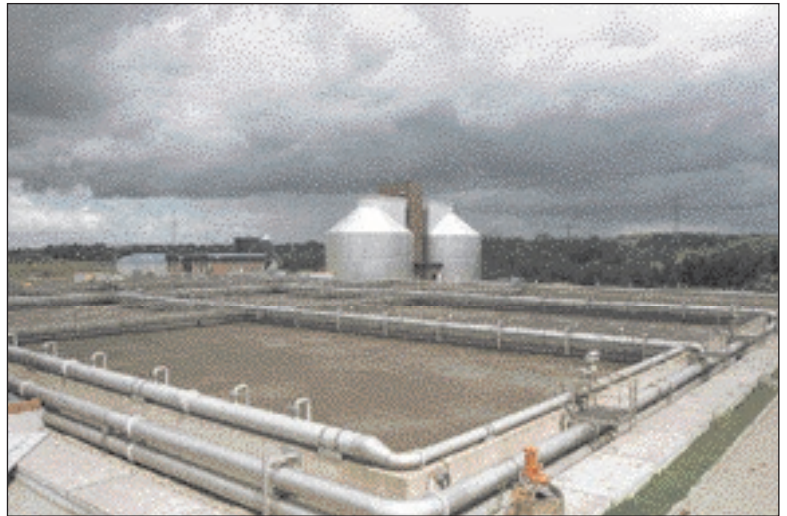
1998 wurden die beiden Faultürme auf der Kläranlage in Schwerin-Süd in Betrieb genommen. Die Menge an übrigbleibendem Rohschlamm wurde dadurch deutlich reduziert.
