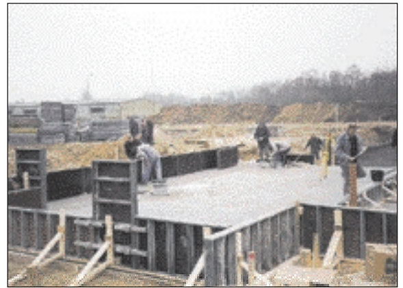
Höchsttempo auf dem Baugelände in Stern Buchholz Fotos: SAS
