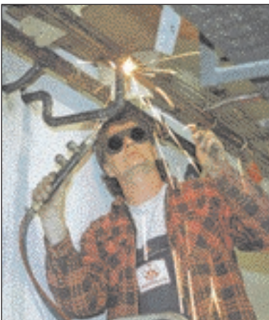
Kellerebene Gang 8: Hier werden unter anderem die Heizungsrohre erneuert
