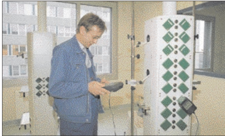
Norbert Laudan von der Firma Elektroanlagenbau-Möller überprüft die Steckdosen an den Deckenversorgungsampeln auf den Zimmern der Intensivstation Fotos: max
