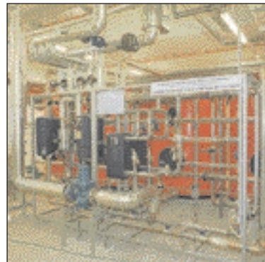
Hochleistungstechnik in Sachen Klima, Strom und Lüftung auf allen Ebenen des neuen Hauses Fotos: max
