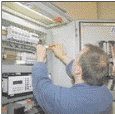
Uwe Lange von der Firma IBA kontrolliert den Schaltschrank zur Überwachung der Netzersatzversorgung auf Ebene 10
