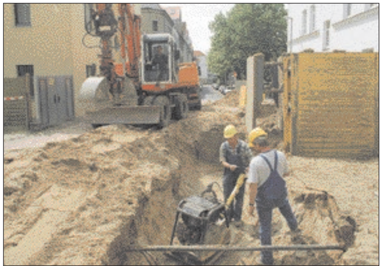
Wilfried Schüssler (links) und Siegmund Fitzel vom Tief- und Brunnenbau füllen den Graben in der Seestraße, in dem zuvor die neuen Abwasserrohre verlegt wurden. Foto: Becker
