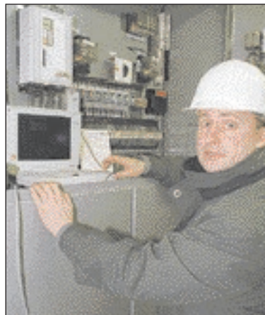
Mitten im Strom: Rainer Mokhardt, Ingenieur für Netzschutz, überprüft ein Computerrelais im Umspannwerk Wüstmark
