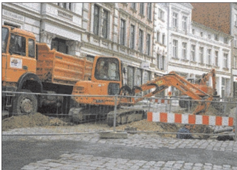
Friedrichstraße: größte innerstädtische Baumaßnahme des Jahres in Schwerin Foto: td
