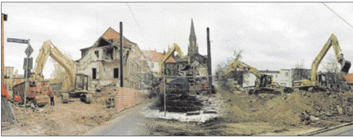
Schritt für Schritt verschwunden: Die alten Häuser in der Franz-Mehring-Straße wurden abgerissen
