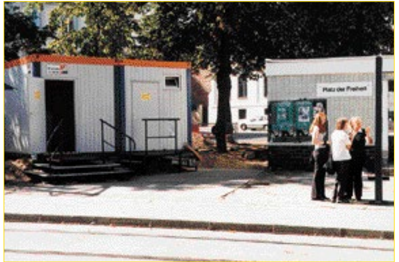
Baucontainer künden von der Umgestaltung der Haltestelle „Platz der Freiheit“.
