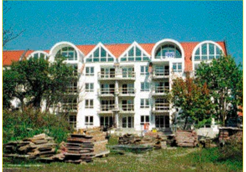
Auch wenn hier noch Bauarbeiten laufen, wird das Gebäude pünktlich übergeben.
