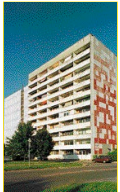
Soll mal so schön werden wie das Lessing-Hochhaus: Die Doppelkombination in der Brechtstraße wird erstmalig in Schwerin ein modernes Abluftsystem haben. hh
