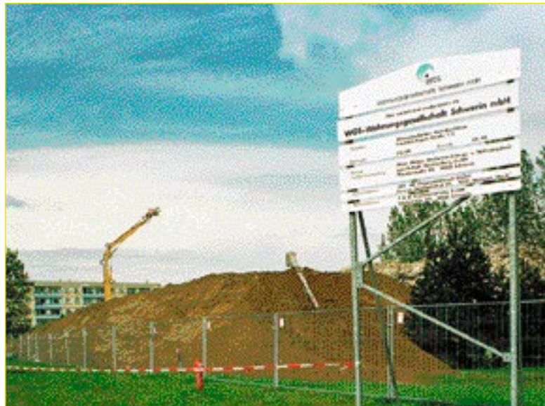
Nur ein großer Schuttberg ist vom Elfgeschoss in der Engelsstraße übrig geblieben
