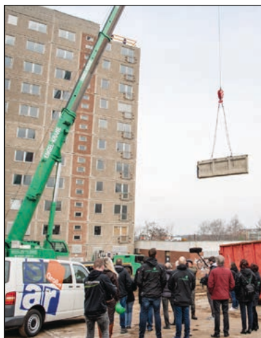
Am 19. Februar wurde mit Hilfe eines Mobilkrans die erste Platte des Hochhauses in der Rostocker Straße herausgehoben Foto: mp
