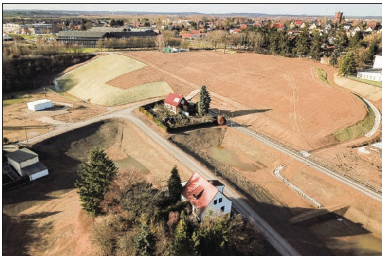
Auf der Deponie am Finkenamp ist die Baustelle mittlerweile geräumt und es lässt sich erahnen, welch grüner Ort sich hier entwickeln könnte Foto: ZGM
