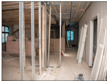
Voraussichtlich bis September entstehen hier die neuen Räume für den Kinder- und Jugendnotdienst der AWO
