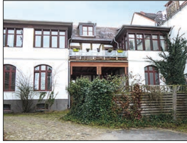
Hochparterre mit separatem Zugang
