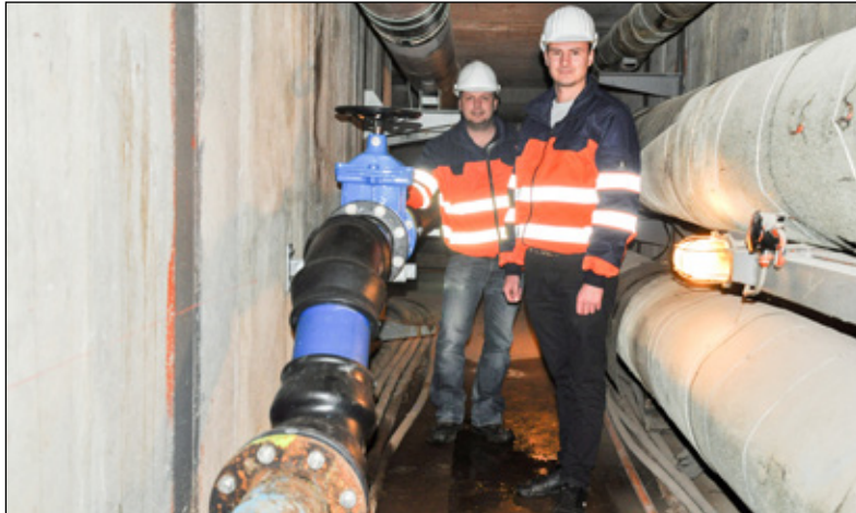
Benjamin Walter und Johannes Ohl prüfen vor Baubeginn die Schnittstelle der alten und neuen Trinkwasserversorgungsleitungen im Lankower Kollektor Foto: ba
