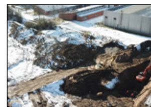
Baustelle Berufliche Schule Technik in Lankow
