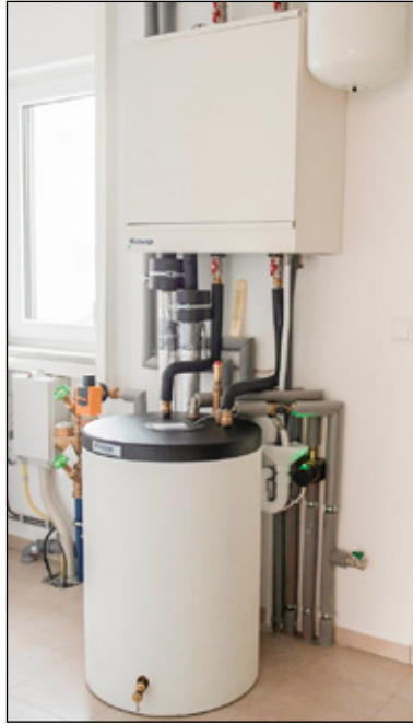
Fernwärme-Kompaktstation mit Warmwasserspeicher Foto: Stadtwerke Schwerin
