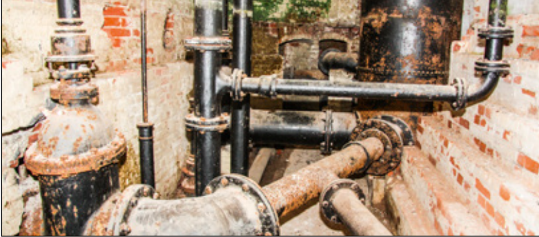
Nach mehr als 100 Jahren wurde der Rohrkeller des Wasserturms umfangreich saniert. Korrosion setzte den Leitungen zu. Auch die Klinkerwände wiesen starke Schäden auf. Fotos: WAG
