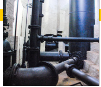
Nach der Sanierung stimmt nicht nur die Optik. Auch die Funktionsfähigkeit ist verbessert
