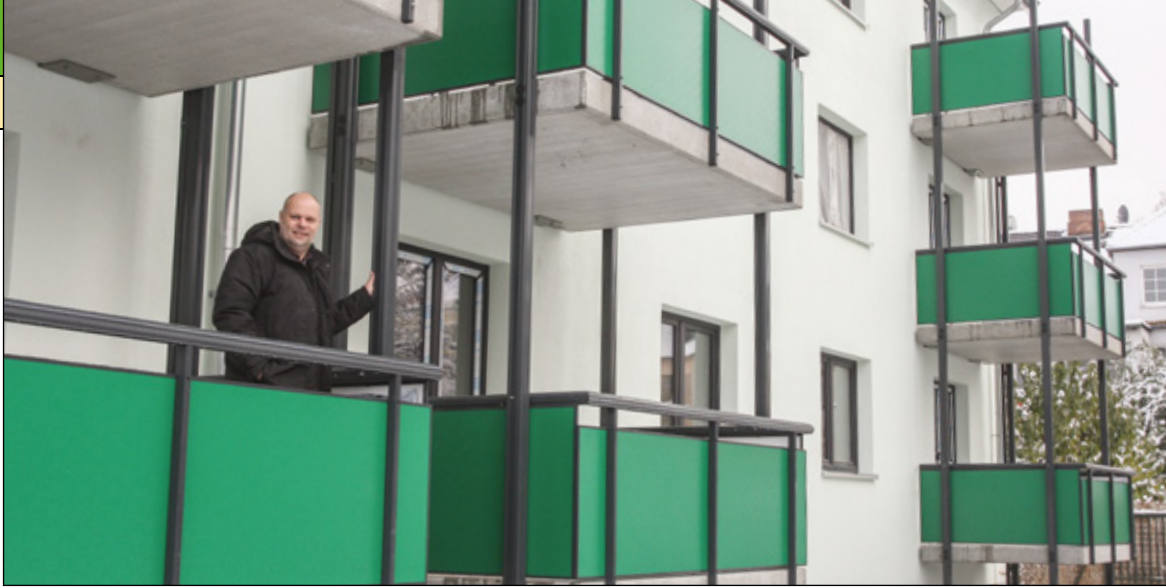
Ende Oktober erhielt das Wohnhaus die neue Balkonanlage. Projektbetreuer Stefan Wunsch ist sich sicher, dass die Mieter im neuen Jahr einziehen können Fotos: maxpress
