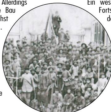
Kanalisationbau in der Lehmstraße, der Transport von Fäkalientönnchen und die Kläranlage Bornhövedstraße Repros: Stadtwerke
