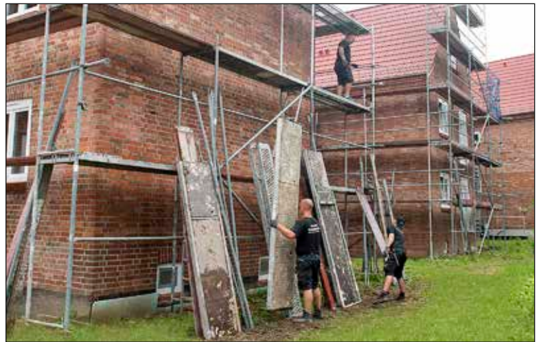
Nach der erfolgten Fassadensanierung werden die Gerüste entfernt Foto: maxpress/at
