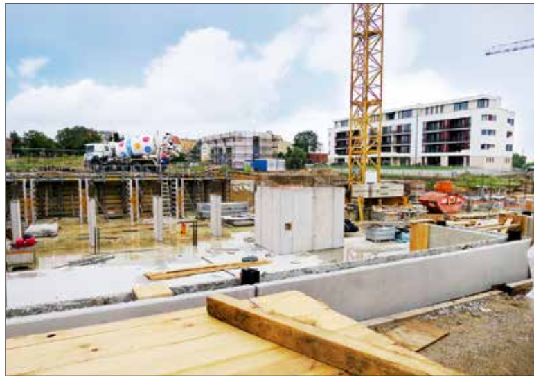
In der Amtstraße gehen die Bauarbeiten zügig voran. 41 Eigentumswohnungen sollen bis Ende 2016 fertiggestellt sein Fotos: Sparkasse
