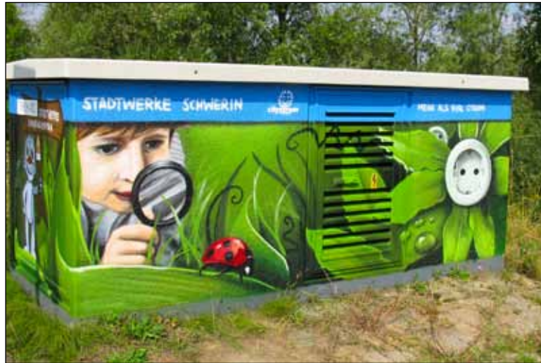
Wie hier in der Grabenstraße werden mehr und mehr Trafostationen in der Landeshauptstadt mit künstlerischen Motiven gestaltet Foto: SWS
