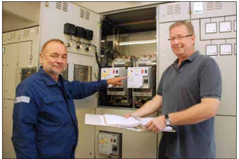
Elektromonteur Horst Scheffler (l.) und Jörg Hahn, Leiter des Meisterbereichs Elektrotechnik, besprechen anstehende Wartungsarbeiten Foto: maxpress/ba
