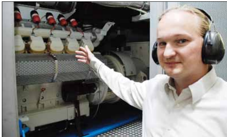
Christian Friederich ist Energiebeauftragter der WAG und stolz auf das Blockheizkraftwerk, in dem das auf der Kläranlage gewonnene Gas zu Strom verwandelt wird Foto: ba
