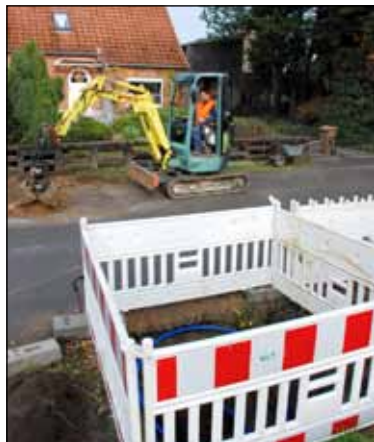
In der Gadebuscher Straße wurden Hausanschlüsse erneuert Fotos: maxpress/ba
