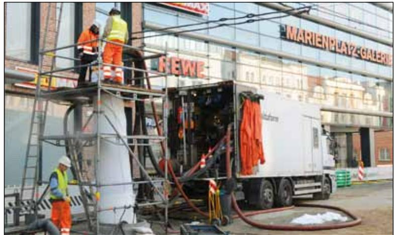
Statt in teurer, zeitraubender offener Bauweise zu arbeiten, konnte die SAE für die Sanierung von Mischwasserkanalabschnitten das Inliner-Verfahren nutzen Foto: Hans-Dieter Hentschel
