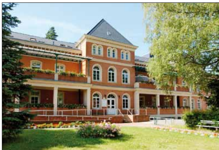
Die Klinik für Alterspsychiatrie auf dem Gelände der HELIOS Kliniken Schwerin Foto: HELIOS
