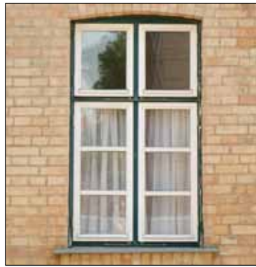
Auch das Fenster ist typisch für die Bauweise in Mecklenburg-Vorpommern
