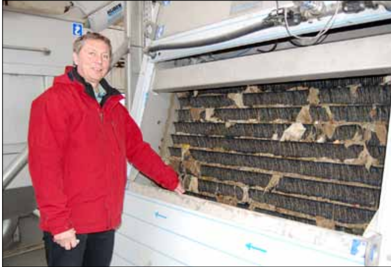
Jörg Flissakowski, Ingenieur Instandhaltung bei der WAG, präsentiert den neuen Rechen, an dem alles Schweriner Abwasser vorbei muss Foto: maxpress/mw
