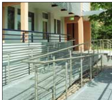
Rampen an den Hauseingängen für unbewehrten Zugang zu den Wohnhäusern
