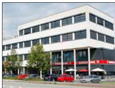
Wo einst Hochhäuser standen, wurden Dienstleistungszentren wie die Dreesch-Arkaden von der WGS gebaut Foto: maxpress
