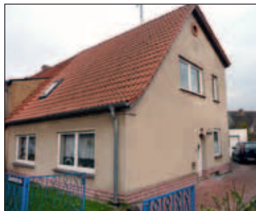
Der Spitzboden ist ausbaufähig
