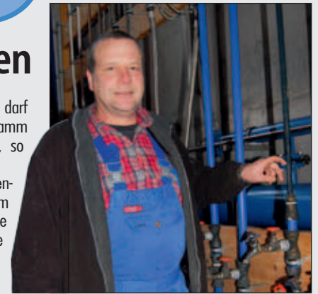
Jörg Wiegandt, Stationswart im Wasserwerk Mühlenscharm, zeigt ein Kupferrohr. Durch Luft und Feuchte hat sich darauf eine dunkle Schutzschicht gebildet maxpress/mw
