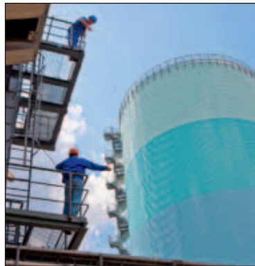
Blick auf den Fernwärmespeicher
