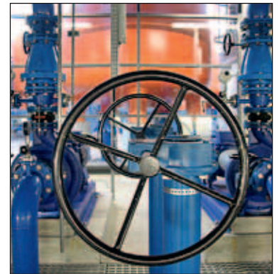
Im Wasserwerk Fotos: MV-FOTO e. V.
