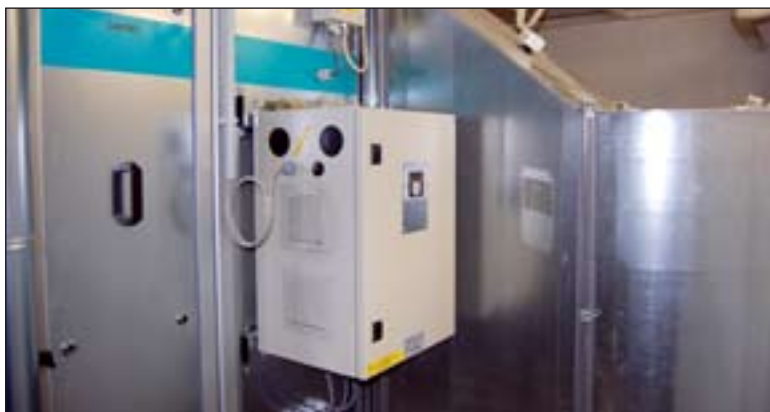
Die neue Anlage im Keller wird die Heizkosten senken
