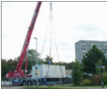
Das neue Unterwerk beim Aufbau durch den 180-Tonnen-Kran
