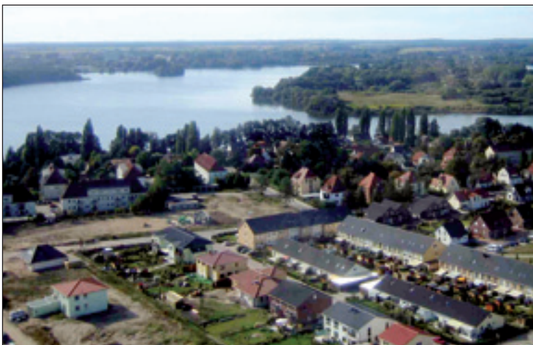
Letzte Vorbereitungen: Die Freiflächen im dritten Bauabschnitt können bald bebaut werden. Foto: privat
