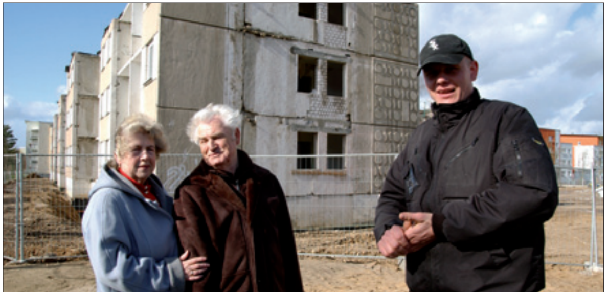
Ingrid und Siegfried Peters (v.l.) schauen schon mal vorbei: Voraussichtlich im August werden sie eine Drei-Raum-Wohnung in der Tallinner Straße beziehen. Bauleiter Mario Boldt klärt sie auf über den Stand der Dinge auf der Baustelle Foto: lk
