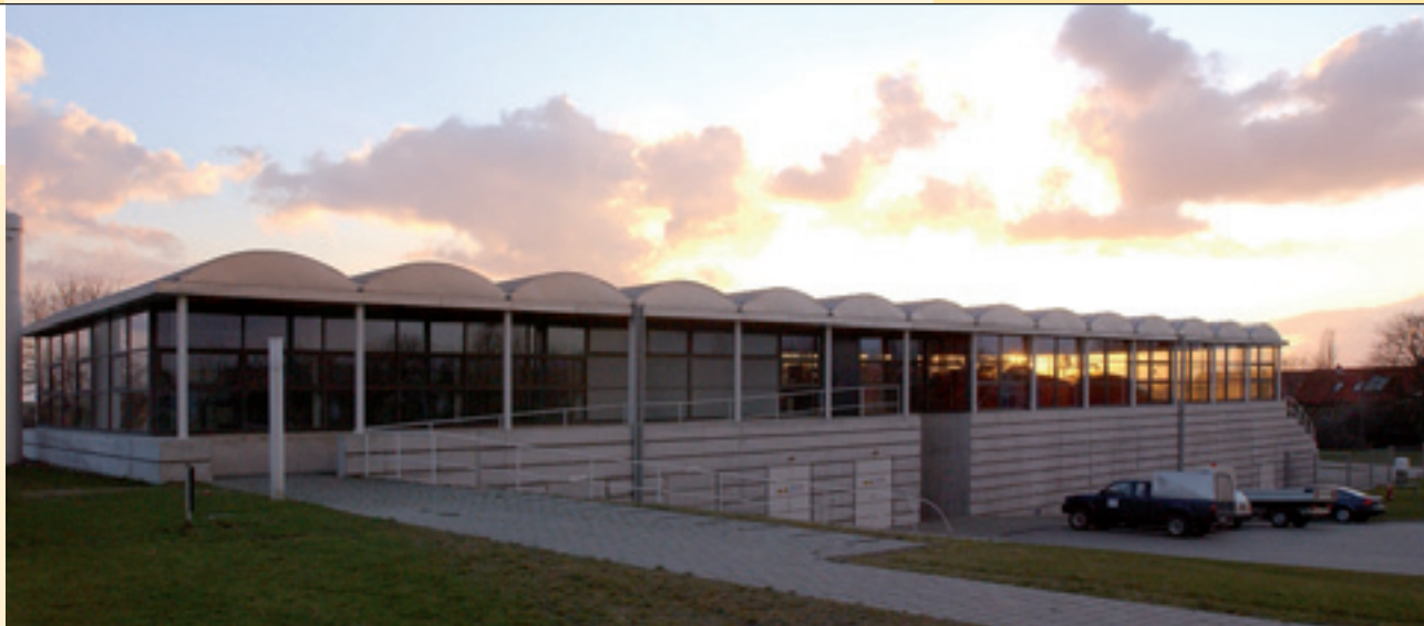
Bestes Trinkwasser für die Landeshauptstadt Schwerin: das Wasserwerk Mühlenscharm
