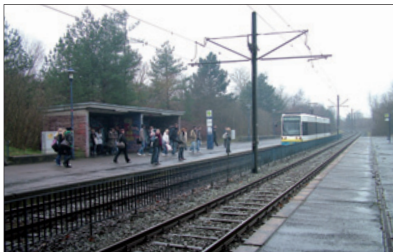
Die Straßenbahnhaltestelle in Schwerin Süd wird im März grundinstandgesetzt, nachdem ein Behelfsbahnsteig installiert worden ist Foto: nvs
