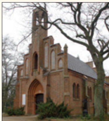
Das neu gedeckte Dach gibt Schutz
