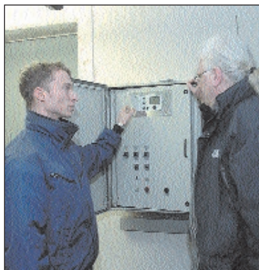
Jens Dornbusch hat den Heizungsregler im Schaltschrank eines Hochhauses so programmiert, dass er sich via Modem auch aus der Ferne steuern lässt. Fotos: max
