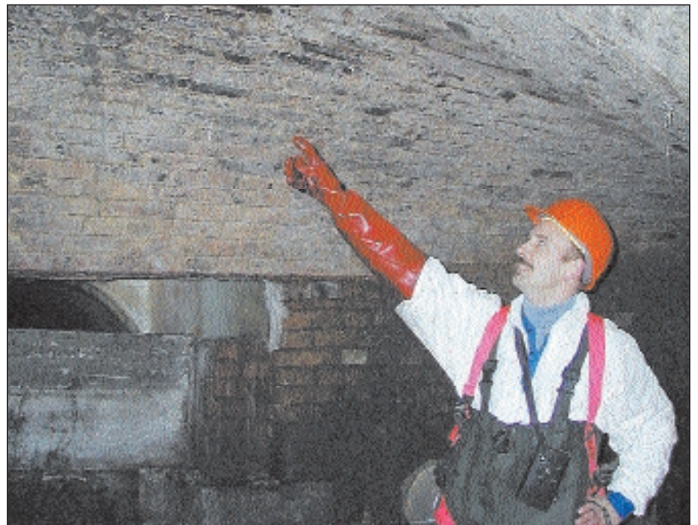
Unterwegs im Untergrund: SAE-Mitarbeiter Peter Bongartz inspiziert die Gewölbekammer unter der Röntgenstraße
