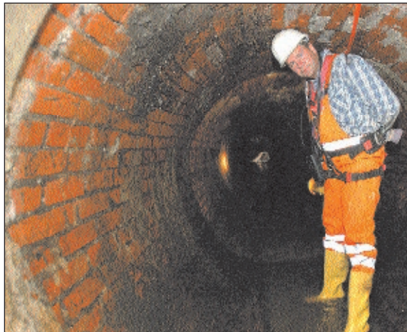
Die Kanäle unter den Straßen Schwerins dienen bei starken Regenfällen auch als Speicher Fotos: maxpress
