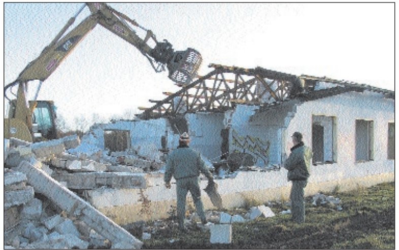
Abriss des ehemaligen Vereinsgebäudes am Burgsee
