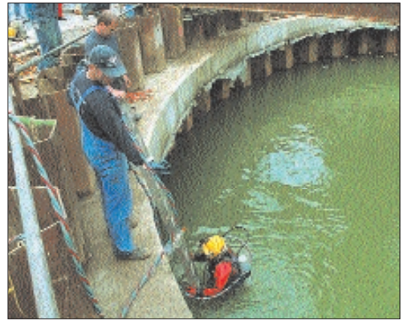
2001 wurde das Regenrückhaltebecken am Platz der Jugend gebaut. An der Oberfläche ist davon kaum etwas zu sehen
