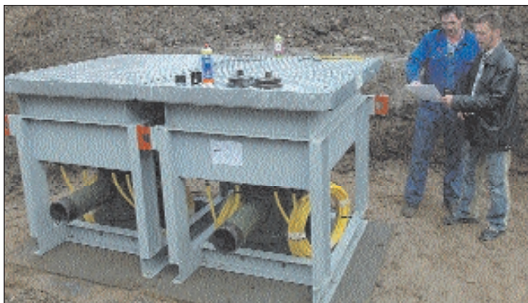
Unterirdischer Einbau: Gasmonteur Frank Münch (links) und Dirk Pietrusska, Meister Netzbetrieb Gas bei den Stadtwerken, an der Gasdruckregelstation in der Steinstraße
