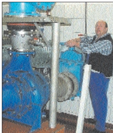
Michael Kröger im Pumpwerk in Görries. Auf 120 dieser Anlagen gibt er acht
