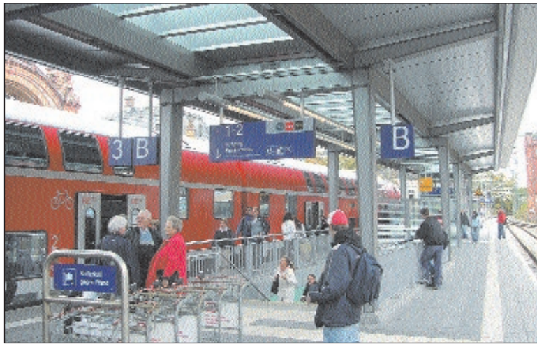
Die Umbauarbeiten am Hauptbahnhof sind abgeschlossen
