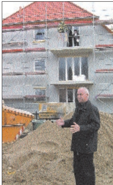
Nach der Rede von NCC-Regionalleiter Wolfgang Heßler (unten) sprach Zimmermann Hans-Jürgen Große den Richtspruch Foto: fh
