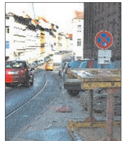
Die Bauarbeiten in der Franz-Mehring-Straße gehen weiter Foto: max
