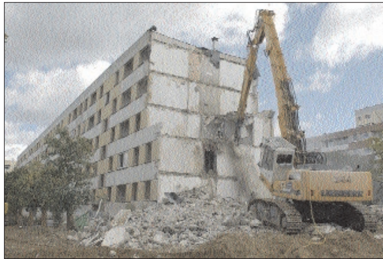
In der Parchimer Straße knabbern die Bagger die Platte ab
