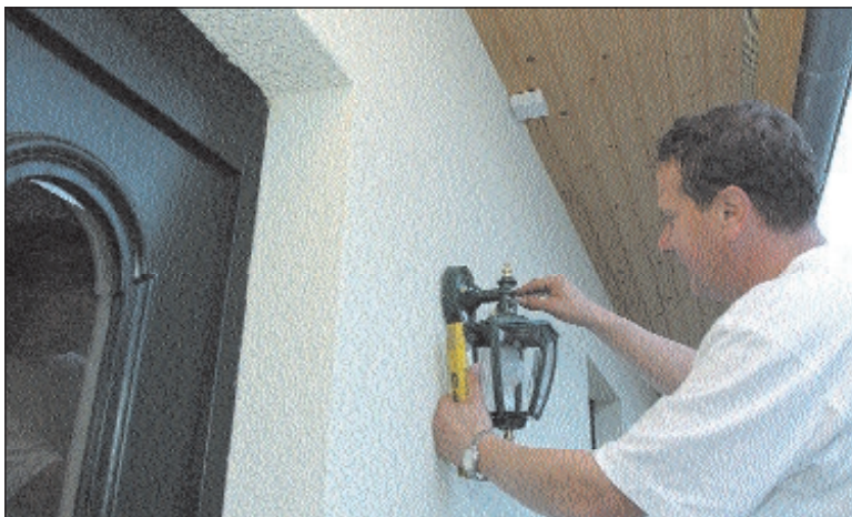
Wolfgang Block baut die Außenbeleuchtung an, den Rest machen die Handwerker Foto: max
