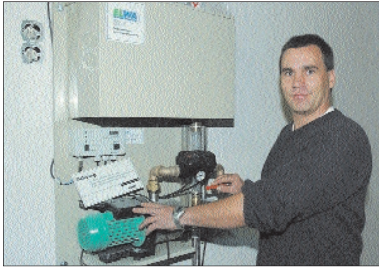
Torsten Goosmann, Abnahmeleiter bei der WAG, kontrolliert die korrekte Installation eines Hausanschlusses für das kostbare Schweriner Nass Foto: max
