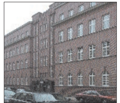
Seit vier Jahren dient das Gebäude als Verwaltungssitz der WGS Fotos: max
