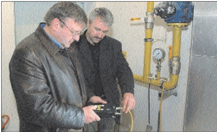
Heizung-, Klima-, Sanitär-Meister Roland Ulrich (li.) und Stadtwerke-Mitarbeiter Jörg Tiedemann überprüfen die Hausgasleitungen einer Heizungsanlage Foto: max
