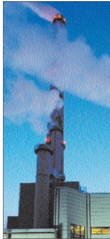
Begrüßt die Besucher Schwerins schon von weitem: Der 183 Meter hohe Schornstein am Heizkraftwerk in Süd Fotos: max
