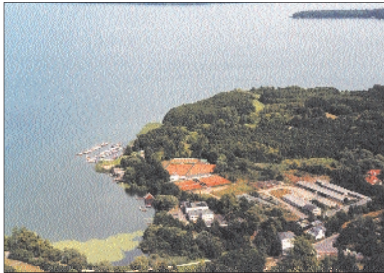
Am 14. Januar ist Baustelleneröffnung an den Küchengärten (lange Hallen rechts im Bild) durch Oberbürgermeister Norbert Claussen Foto: Stadt
