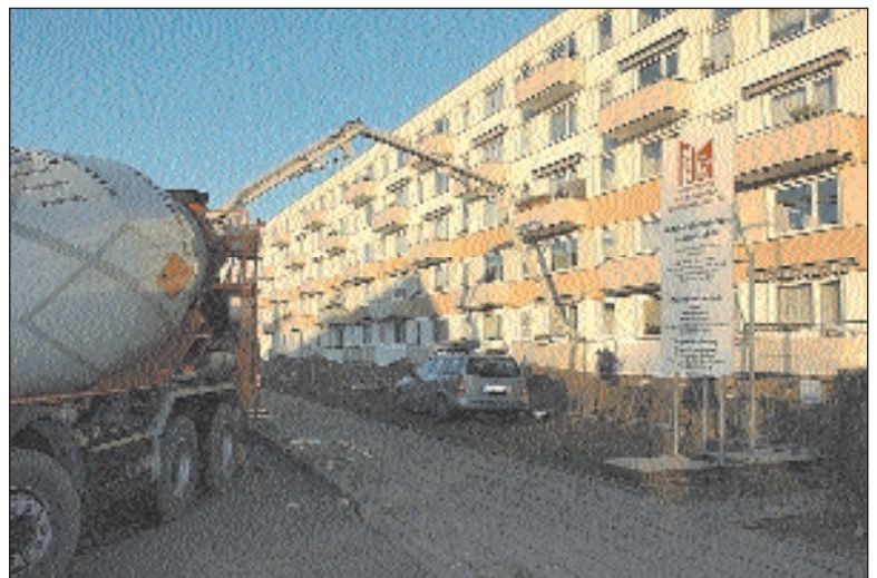
Nun beginnt die Modernisierung in der Lessingstraße 26 bis 38. Alle Wohnungen erhalten einen Balkon. Zehn Wohnungen werden weitestgehend barrierefrei sein Foto: max
