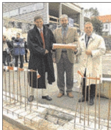
Neuer Sozialdezernent Dr. Hermann Jung-hans, Verwaltungsdirektor Dr. Hagen Marin und der ehemalige Sozialdezernent Jochen Rößler (v.l.n.r.) legten den Grundstein für die neue Krankenhausküche Foto: max
