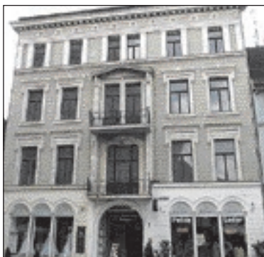
Schloßstraße 12. Viergesch. Fachwerkbau (Einzeldenkmal), Seitenfl., 6-gesch. Fachwerkgeb. z. Klosterstr., Bj. 1845, schlechter Bauzust., Grdst. 848 qm, Nutzfl. Schloßstr. 761 qm, Seitenfl. 523 qm, Klosterstr. 410 qm, Verkehrsw. 524.075 Euro
