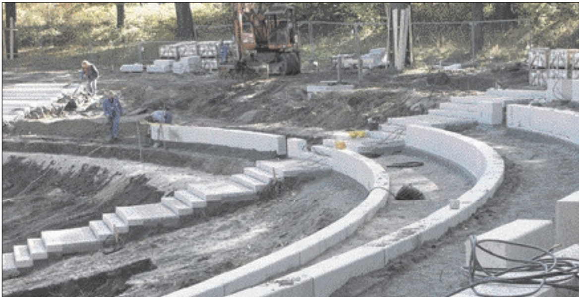
Schon erkennbar: Zwei Traversen, die ab Mai 2003 Platz für 2.000 Zuschauer bieten, werden montiert
