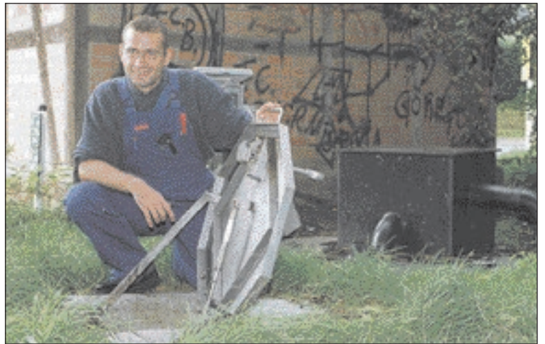
Frank Conell ist Ver- und Entsorger bei der Schweriner Abwasserentsorgung. Für hauspost öffnete er den Deckel der biologischen Abluftbehandlungsanlage in Mueß. Die Anlage sorgt für eine deutlich geringere Schadstoffemission. Foto: no
