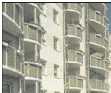
Bereits 1998 begann die SWG mit Grundrissänderungen und Balkonanbauten in der Leibnitzstraße.
