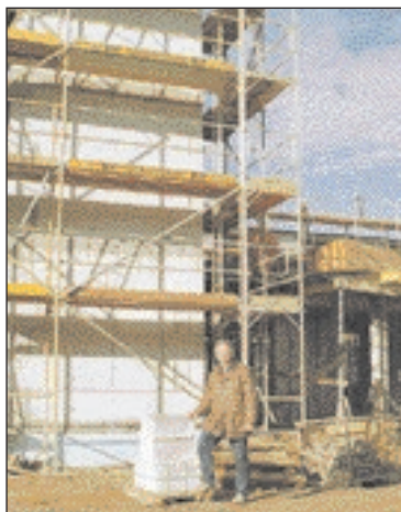
Ausnahmsweise und nur fürs Foto mal ohne Schutzhelm: Bauleiter Hanno Ecklebe an der Vidiner Straße. Foto: Hoefler
