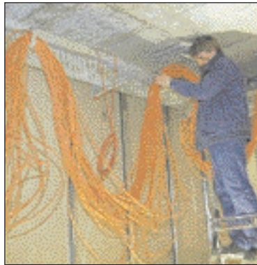
Über 500 km Kabel für die Elektroversorgung im Haus O verlegt
