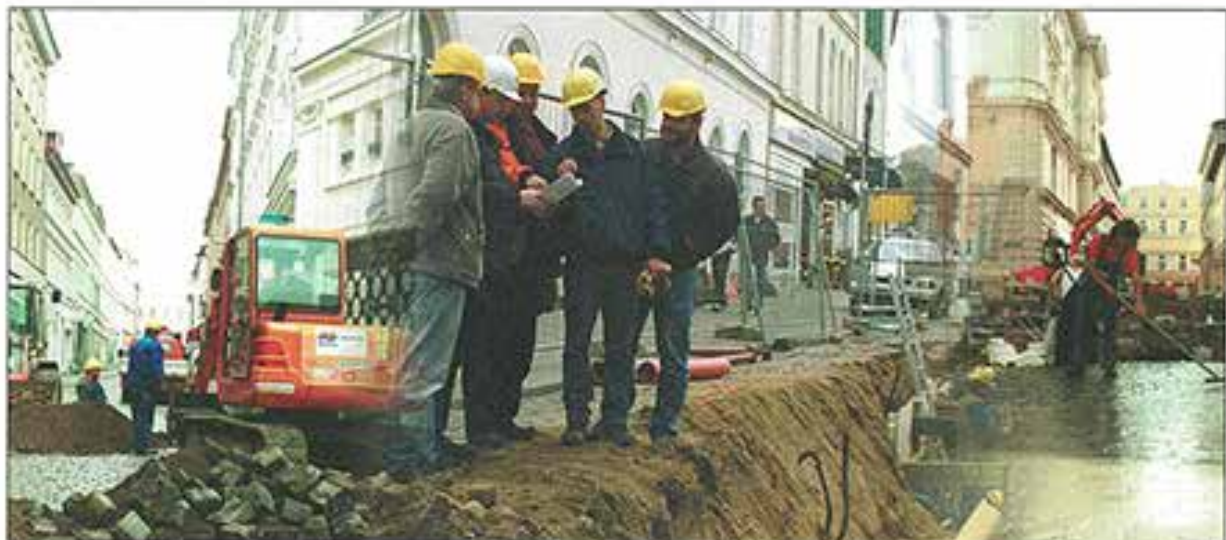
Sanierung Friedrichstraße: Erneuert wurden Gas-, Strom- und Wasserversorgung sowie ein Abwasserkanal. Fotos: drefohl, Collage: max
