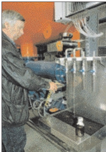
Modernste Technik im neuen Wasserwerk Mühlenscharren. Fotos: max / ch
