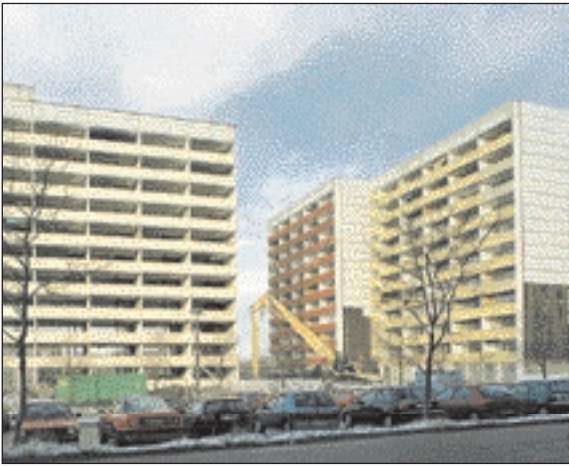
Gleiche Technik wie beim Abriss in der Friedrich Engels Straße: Die Hochhäuser in der Pilaer Straße werden „abgeknabbert“.
