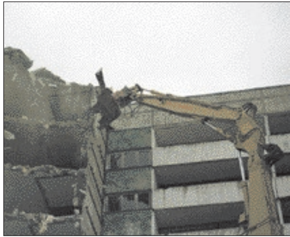
Gleiche Technik wie beim Abriss in der Friedrich Engels Straße: Die Hochhäuser in der Pilaer Straße werden „abgeknabbert“.
