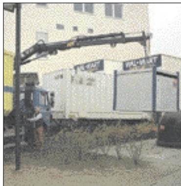
Langer Arm: Am zugesperrten „Walmart“ muss der Kran auf ganze Länge ausfahren.
