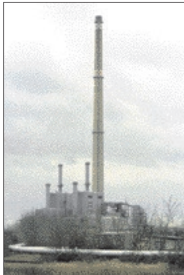
Wichtig: Das Heizwerk in Schwerin Süd.
