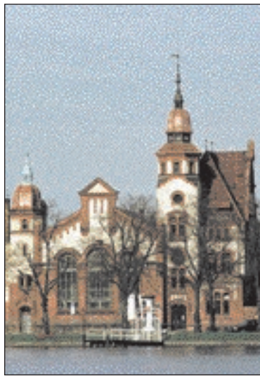
Der Ort an dem alles begann: das alte E-Werk am Pfaffenteich.
