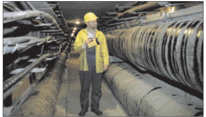
Michael Schlömer beim Abstieg und bei der Kontrolle der Leitungen in einem der beiden Hauptkollektoren auf dem Großen Dreesch.
