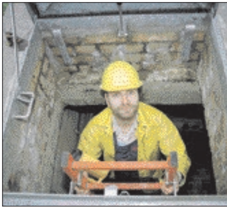
Michael Schlömer beim Abstieg und bei der Kontrolle der Leitungen in einem der beiden Hauptkollektoren auf dem Großen Dreesch.
